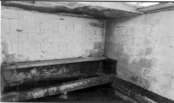
Foto 5: Sustitución de mitorrias
