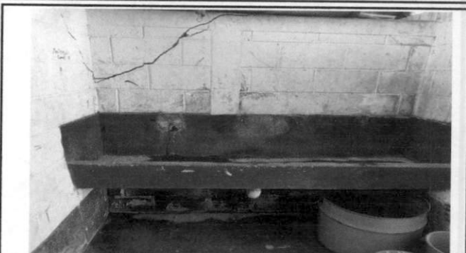
Foto 2: Reparación de muro perimetral de block
