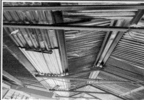
Foto 6: Sustitución de lamina troquelada aluzivo Calibre 26
