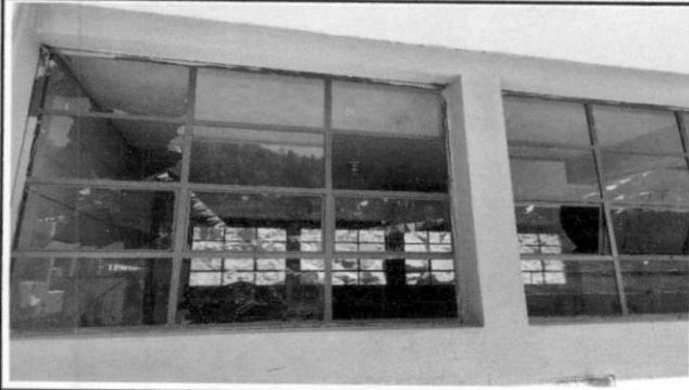
Foto 1: Sustitución de Vidrios
