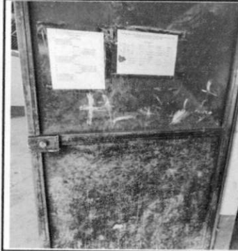
Foto 2: Sustitución de Chapa
