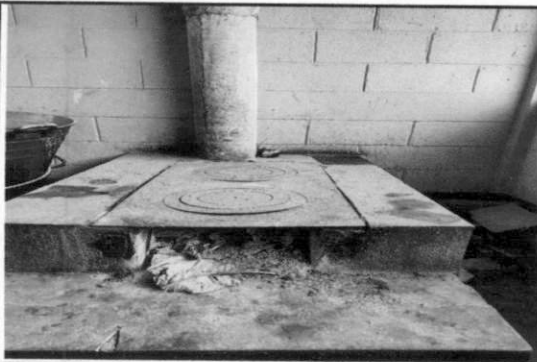
Foto 3: Sustitución de estufa Rural
